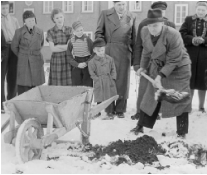
Der 1. Vorsitzende der AWG Rheinmetall Günther Stelter, beim ersten Spatenstich am 13. Februar 1955
